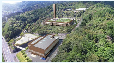
環境美化センター（建設中）
