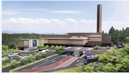
北部クリーンセンター（建設中）
